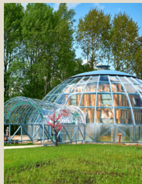
ДОМ ПОД КУПОЛОМ
